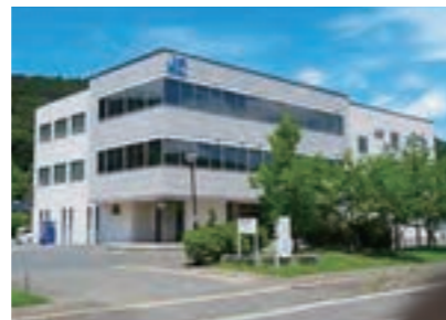
宮城県水難救済会が入居する 宮城県水産会館(石巻)
